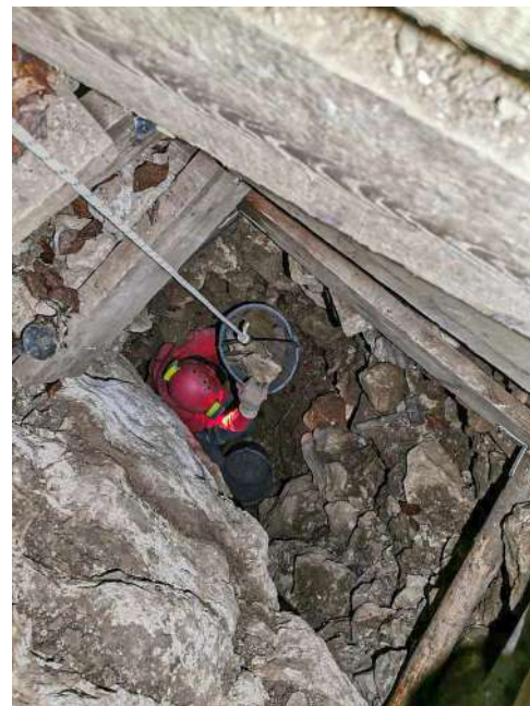
Levo: Na čelu kopanja v Radošci 2. Sredina: Opiranje izkopa v Radošci 2. Desno: Naloženo vedro za transport izkopanega materiala. Foto: Primož Jakopin - Klok
