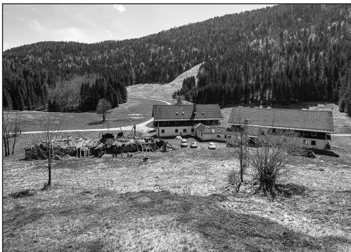
Pogled na Glažuto z bližnje preže. Na sredini in desni poslopji, na levi porušen hlev (foto: Matej Blatnik).
