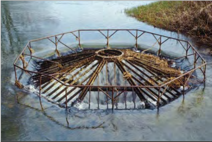
Prva vodna elektrarna v Sloveniji je bila zgrajena leta 1902 v bližini mesta Ljubljana. Na sliki je vidna vodna klet, ki je del elektrarne. Voda teče skozi klet in se nato sprosti v reko. Elektrarna je bila zgrajena v času, ko se v Sloveniji začelo razvijati gospodarstvo. Ljubljana je bila takrat glavno mesto in središče političnega, kulturnega in gospodarskega življenja. Elektrarna je bila zgrajena v času, ko se v Sloveniji začelo razvijati gospodarstvo. Ljubljana je bila takrat glavno mesto in središče političnega, kulturnega in gospodarskega življenja.
