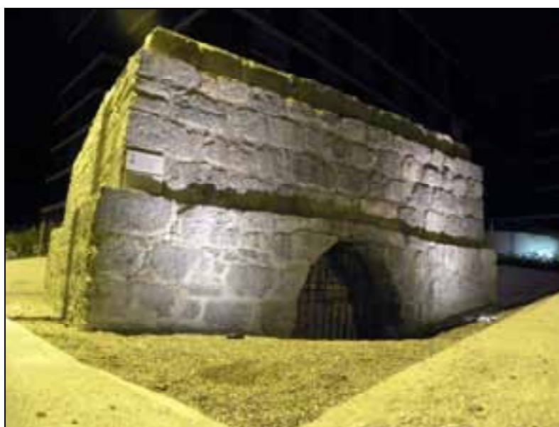
Slika 35: Apnenico, ki je stala pred kamnolomom so pri gradnji ohranili. (Foto: Aleksandra Privšek, oktober 2009)
